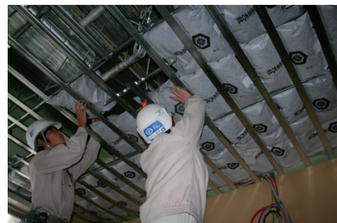
新病棟病室天井への敷設作業
