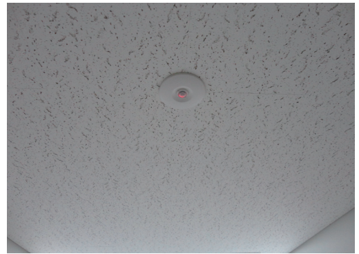
工事後の現場の一部
