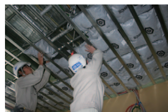
新病棟病室天井への敷設作業
