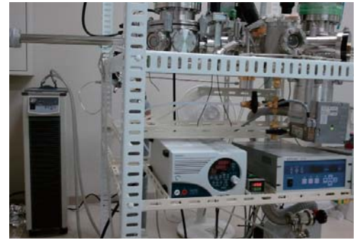
冷却水循環装置
