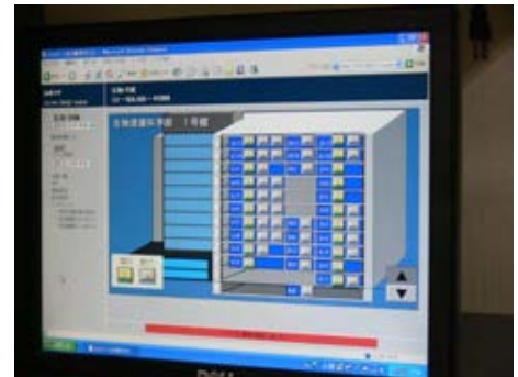
電力モニタリングシステム画面
