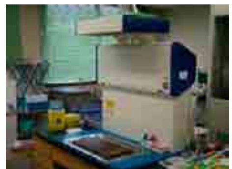
写真14 プッシュプル型局所排気装置
