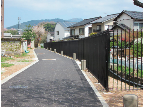
解放感のあるフェンスを設置
