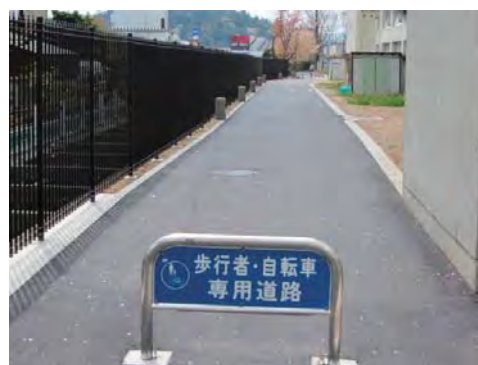
整備後 生物資源科学部2号館東側（北から南を望む）
