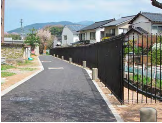
解放感のあるフェンスを設置
