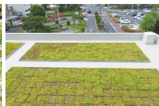
本部棟から見た敷地内院外薬局屋上
