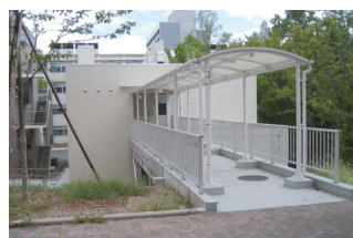
昇降機棟全景(西側)
