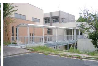
昇降機棟全景(南西側)
