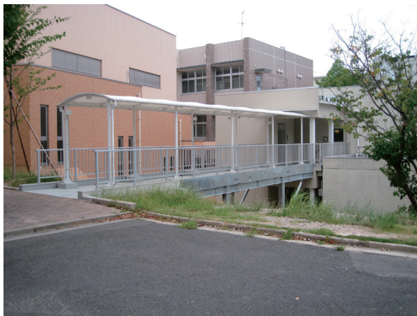
昇降機棟全景 (南西側)
