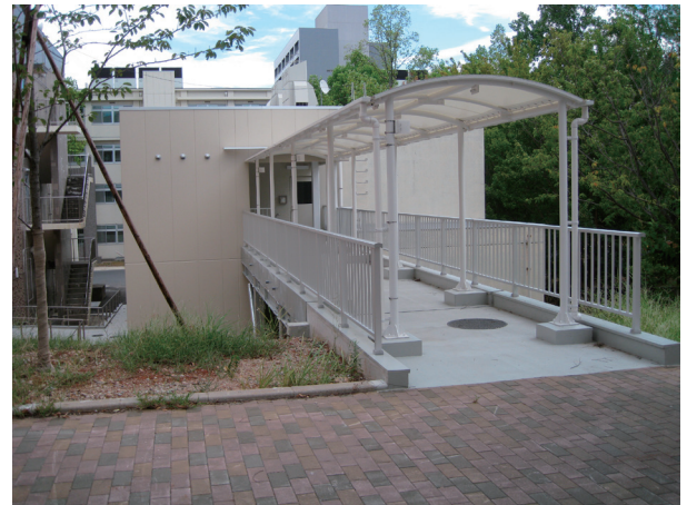
昇降機棟全景 (西側)
