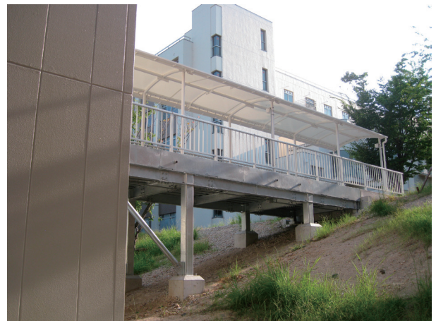
渡り廊下 (下から)
