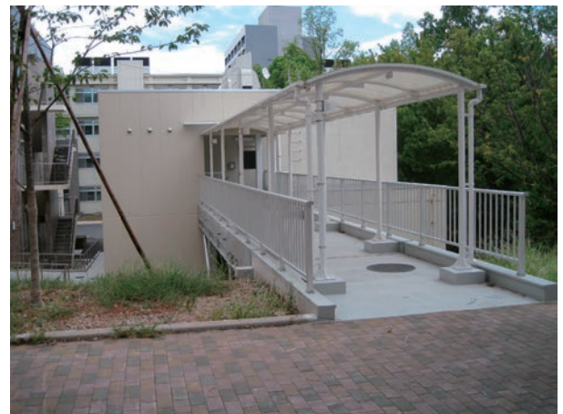
昇降機棟全景（西側）
