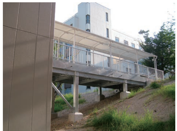
渡り廊下（下から）
