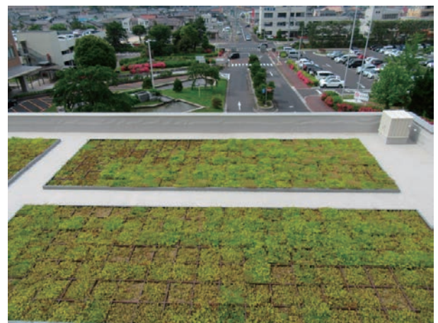
本部棟から見た敷地内院外薬局屋上
