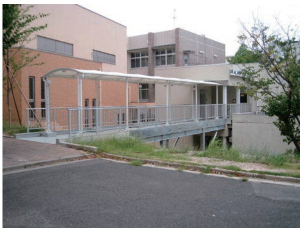
昇降機棟全景（南西側）
