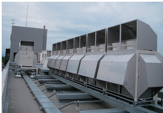
総合理工学部3号館改修後
