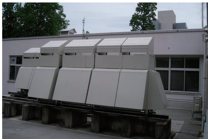
学生センター改修後
