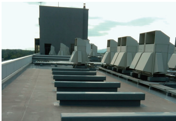
総合理工学部3号館改修前
