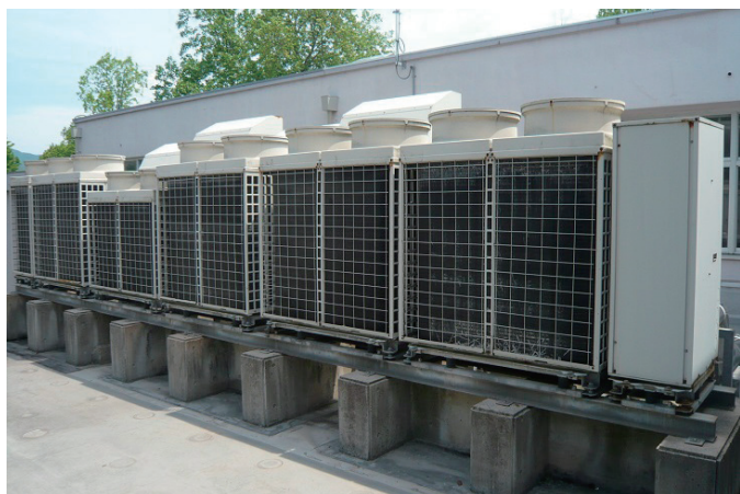
学生センター改修前
