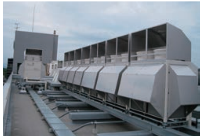
総合理工学部3号館改修後
