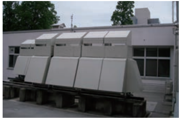
学生センター改修後
