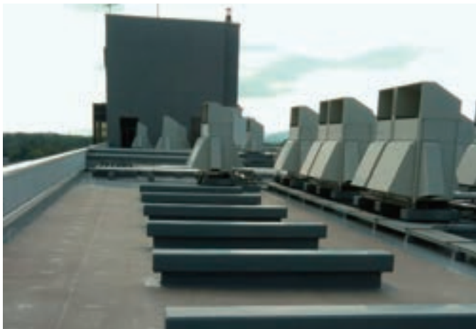
総合理工学部3号館改修前
