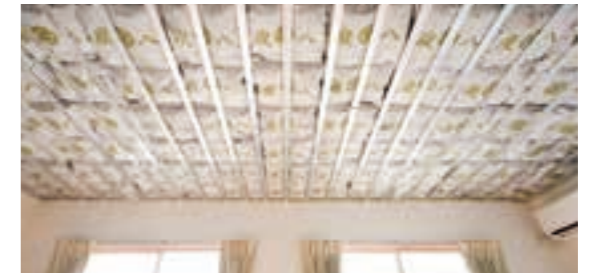
天井に調湿木炭「炭八」を敷設した状況
