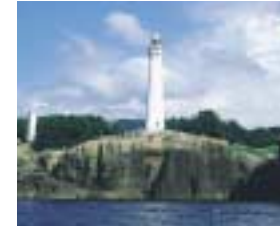
日御碕 明治36年に建築された石積みの灯台で、地上38.8m東洋一の高さを誇り、世界の灯台百選に選ばれています。
