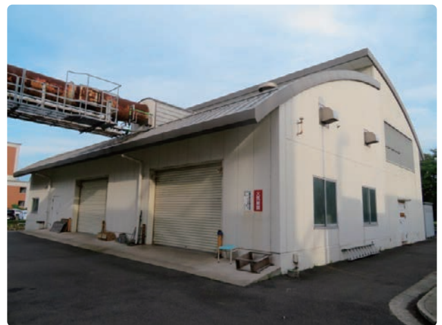
稼働を停止した出雲キャンパス内の焼却炉
