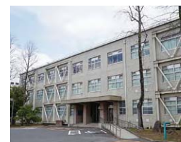
■総合理工学部2号館
