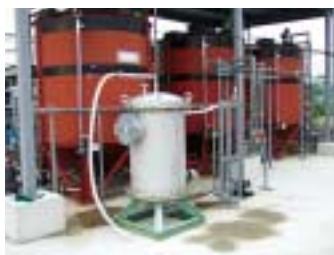
HTCF再生、リン回収装置運転状況
