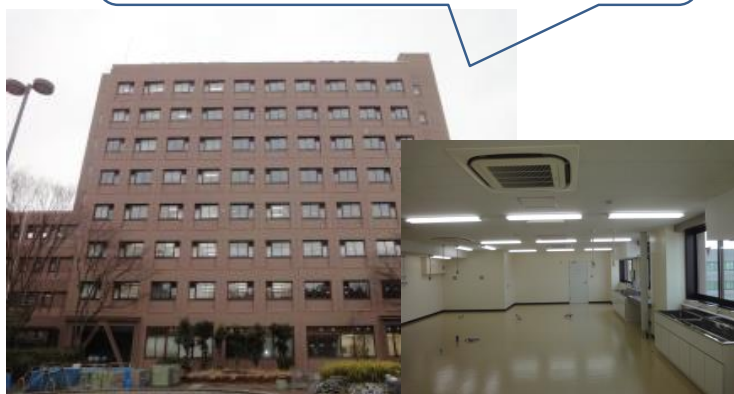
学習・教育・研究基盤の施設としての機能改善改修が完了した医学部基礎研究棟
