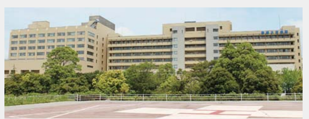
〈地上型ヘリポートと病棟全景〉 病院再開発で病床数を616床から600床として1床当りの面積を拡大し、個室を増やして療養環境の向上を図りました。ICU、NICU、GCUの増床、手術室の増室などで病院機能を強化しています。
