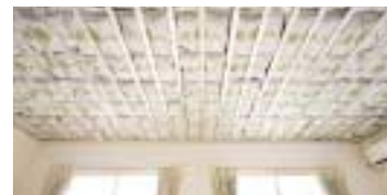
天井用調湿木炭「炭八」を敷設した「炭の家」の内部
