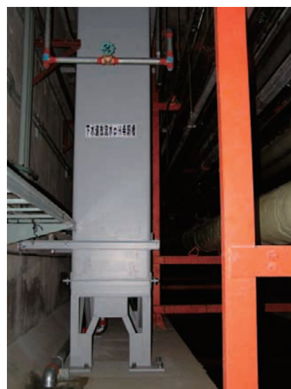
写真58 病院地下ピット希釈槽
