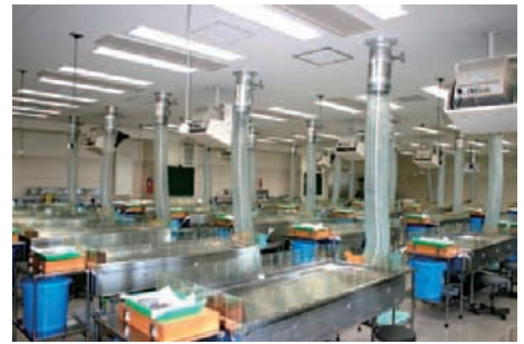
写真19 局所排気装置付実習台
