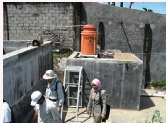
写真2 インドネシア、スマトラ島のアブラヤシ製油工場の排水処理の実証試験 (中央のコンクリート製の水槽が多段土壌層装置)
