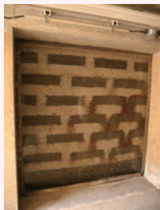
写真1 多段土壌層装置の構造 (福岡県の河川水浄化に設置された装置の内部の様子)
