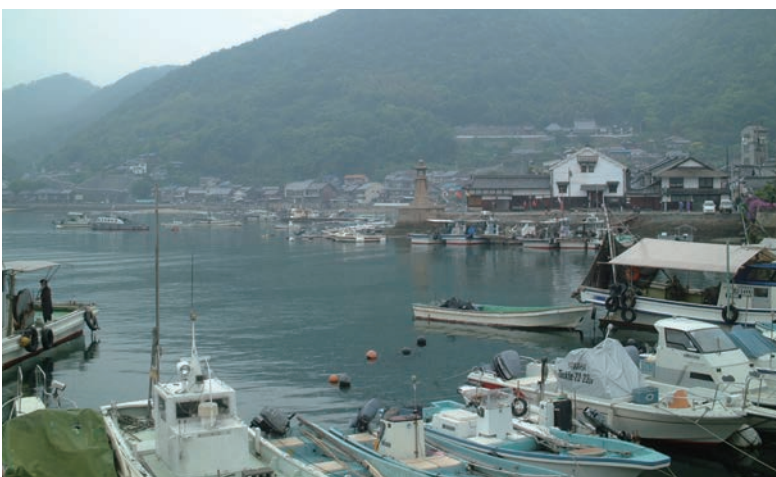
万葉の時代から潮待ちの港として栄えた鞆の浦（広島県福山市）。常夜燈や雁木（がんぎ）など江戸期の港湾施設が現存しています。
