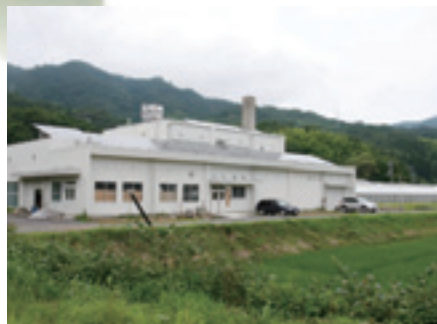
島根大学本庄総合農場内の「植物工場支援・研究施設」の外観。施設は「太陽光発電」や「地中熱利用型ヒートポンプ空調」が活用され、CO 2 削減など環境にも配慮した施設となっています。
