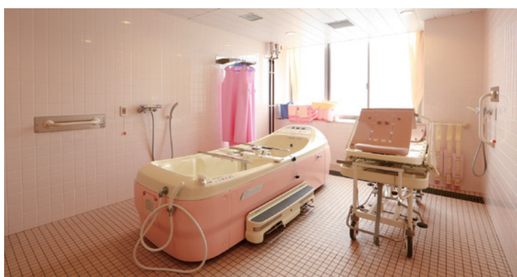
体を動かしにくい患者さんでも横になったまま入浴できる介助浴室。
