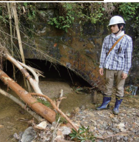
▲トンネル埋没現場の視察。
