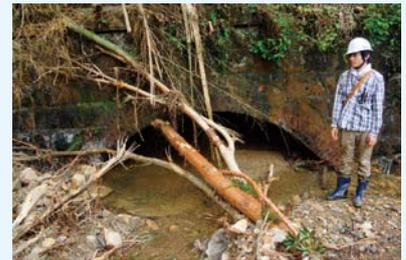
平成 25 年 7 月島根県西部の激甚災害における JR 山口線のトンネル埋没現場
