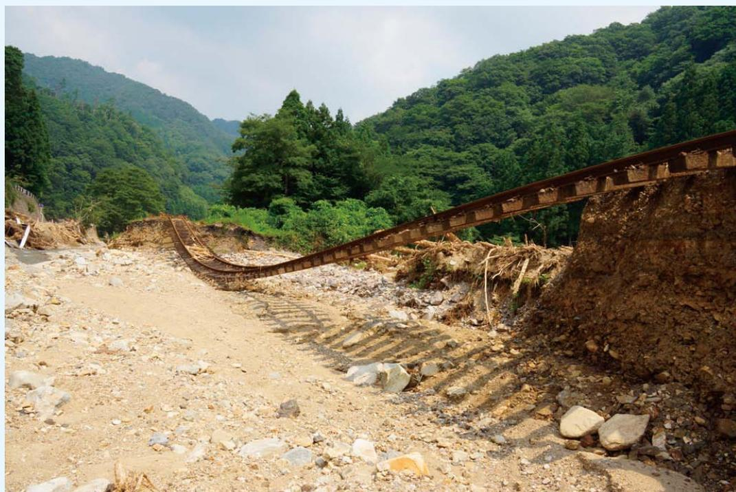
2013年7月山口・島根豪雨災害時洪水によって洗掘されたJR山口線の線路(津和野町)
