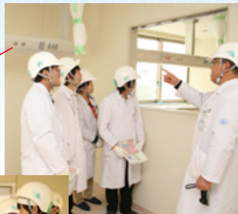
ICUの個室の様子。室内の設備も着実に工事が進んでいます。
