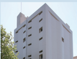
▲積層書庫の結露対策として外断熱を採用。
