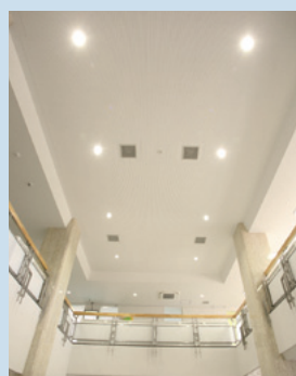
▶エントランスのロビー・ホールや廊下、トイレ等にLED照明を採用。
