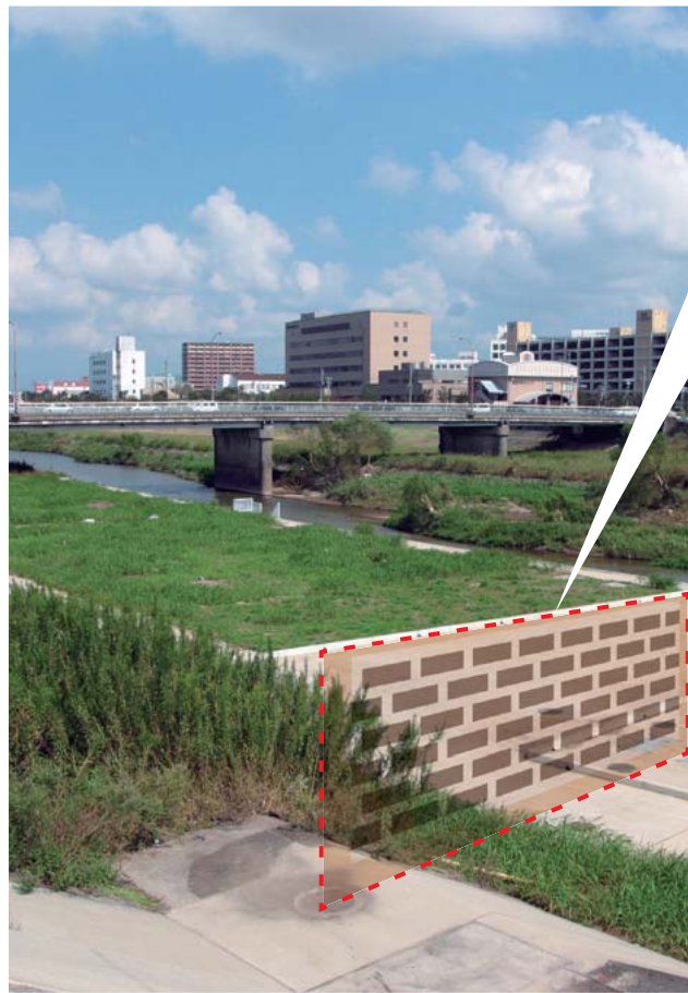
多段土壌層法による河川浄化の一例。福岡県飯塚市を流れる「遠浄化(親水用水化)」を目的に、1750㎡の装置が建設された。
