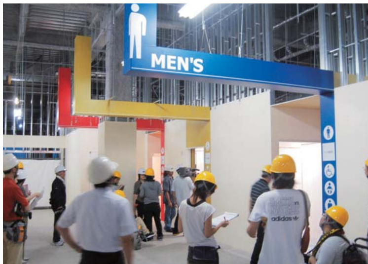
色分けやピクトグラムで分かりやすくデザインされたトイレ。空間的に分かりやすいよう、入口は大きくするなどの工夫がなされている。
