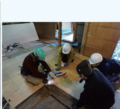
床下地の施工
