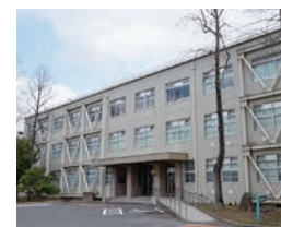
■総合理工学部2号館
