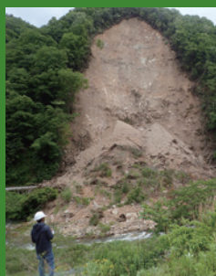
平成30年4月に発生した島根県西部地震による志津見ダム下流大規模斜面崩壊の調査
