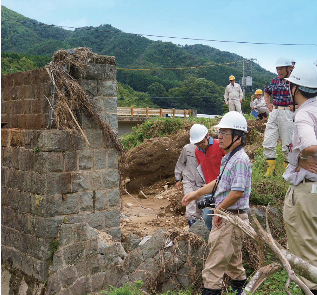
平成25年の激甚災害(洪水災害)調査の様子
