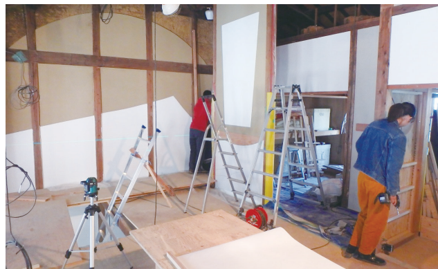
民家改修作業状況
