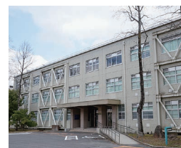
■総合理工学部2号館
