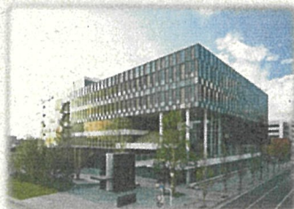
東部地域振興ふれあい拠点施設「ふれあいキューブ」 (1～4階S造、5～6階木造) (埼玉県春日部市)
