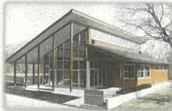
国土交通省：国営常陸海浜公園 自然観察施設棟 (茨城県ひたちなか市)
