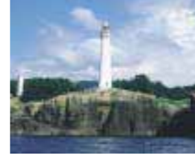
日御碕 明治36年に建築された石積み灯台で、地上38.8m東洋一の高さを誇り、世界の灯台百選に選ばれています。
