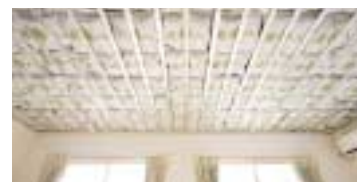
天井用調湿木炭「炭八」を敷設した「炭の家」の内部
