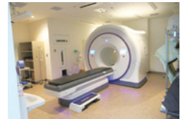
(リニアック室1室内、放射線治療装置)
