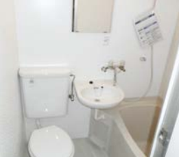
A 棟・C 棟のユニットバス(個室)
