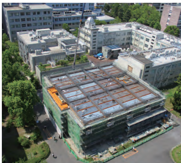
材料エネルギー学部棟の整備状況(2024年6月撮影)
