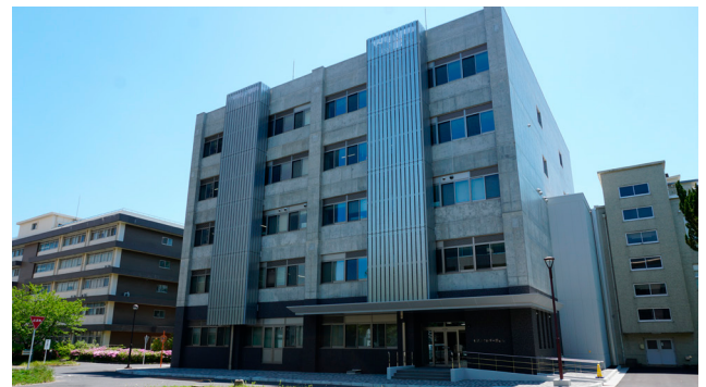
材料エネルギー学部棟
