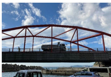
光ファイバセンサを敷設した橋梁
