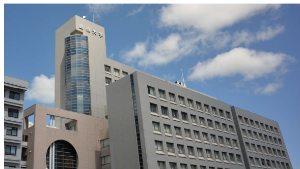
総合理工学部 3 号館
